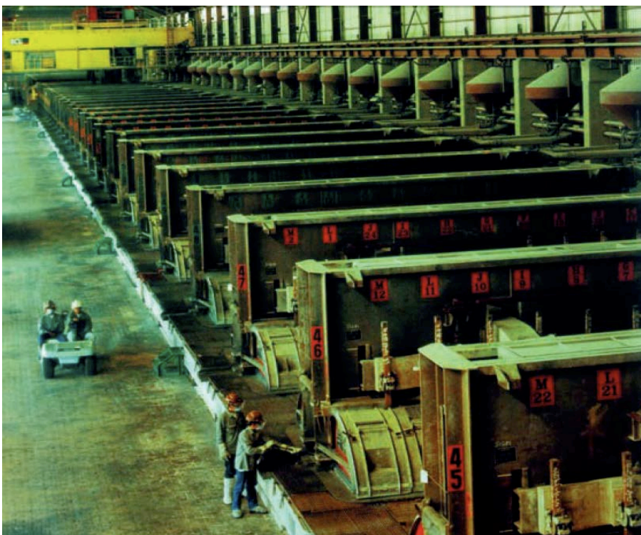
Sala de Cubas, onde se realiza o processo de transformação da alumina em alumínio metálico
